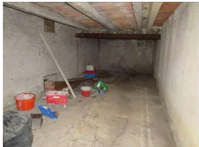
Piccolo fabbricato edificato in aderenza al laboratorio m.n. 274 sub 9, struttura in mattoni di laterizio. Internamente unico vano pavimentato in battuto di cemento, pareti sommariamente intonacate. L'altezza interna è di ml 2,20.
