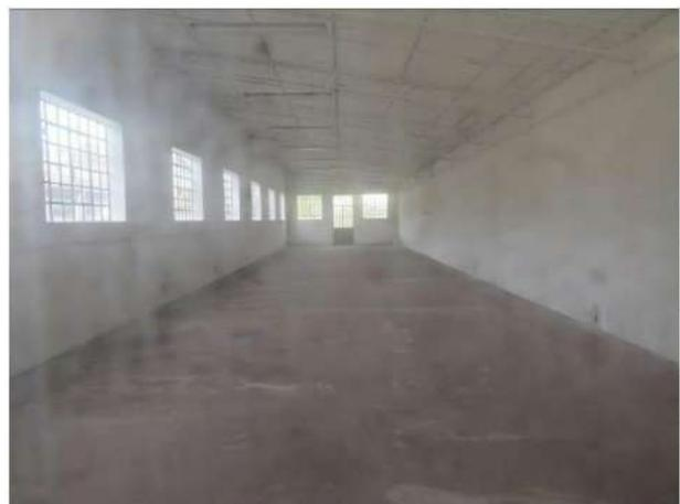
Su un unico livello, senza alcuna partizione interna. Struttura in muratura portante e tetto con travi in metallo e laterizio, copertura in eternit ricoperto. La pavimentazione è in cemento battuto, le pareti sono
