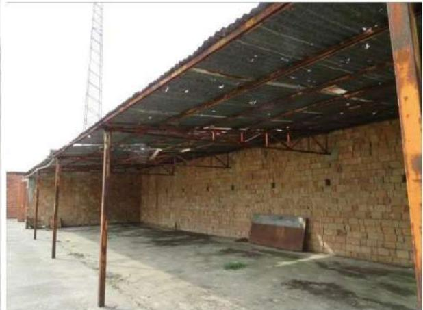
Le tettoie sono costituite dalla muratura di confine in laterizio e struttura metallica. La pavimentazione è in cemento battuto, sono tutte prive di copertura.
